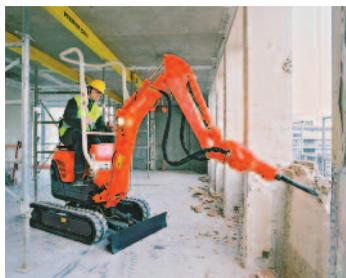
Mini-pelle inférieure à 1 tonne équipée d'un brise béton
