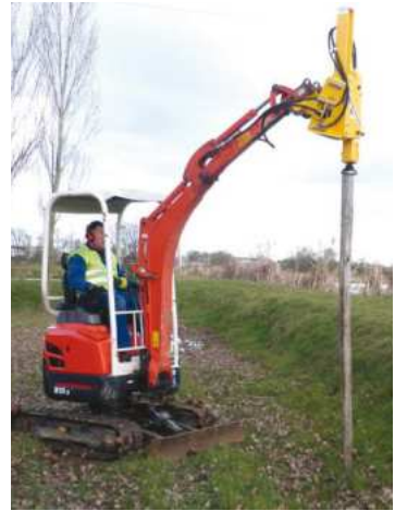
Enfonce pieux pour engins
