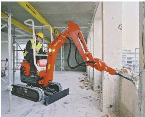
Brise béton sur mini-pelle 1 tonne
