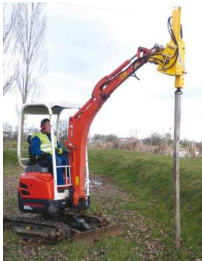
Enfonce pieux pour engins
